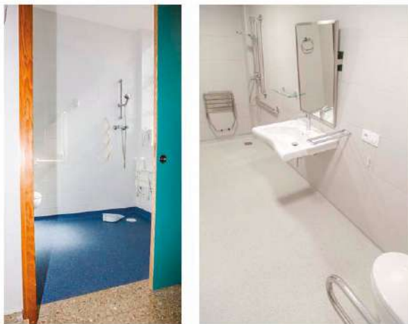
Figura 10: Cuarto de baño adaptado
